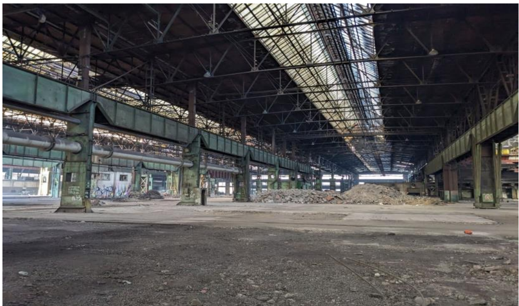
Vue d'ensemble d'un hall du site Esch-Schifflange
